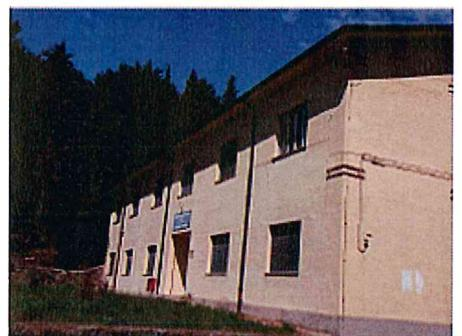
Fabbricato originariamente adibito a scuola di agraria, di notevoli dimensioni ed in mediocre stato conservativo. L'edificio, a pianta rettangolare, si sviluppa su due piani fuori terra ed una piccola porzione interrata, con struttura portante in muratura e copertura a padiglione. Consistenza linda totale pari a mq. 1.034,85 circa.
